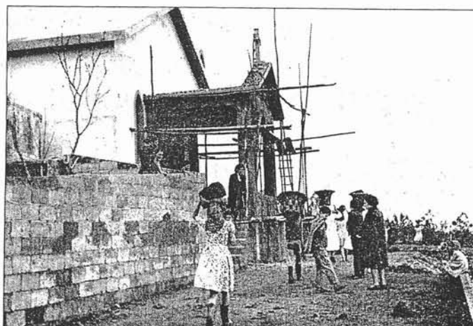
Igreja de São Tiago em construção (Col. Ernesto Pinto Correia)
