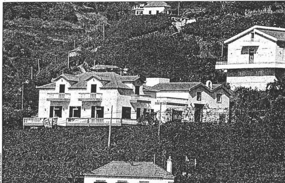
Perspectiva actual do mesmo conjunto arquitectónico
