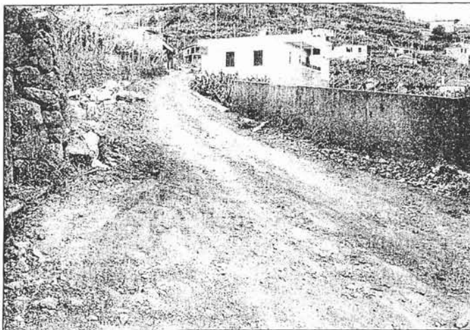
Construção troço Fajã das Freiras - Caminho das Preces
