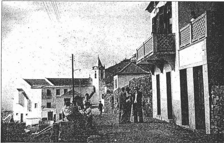
Pormenor da estrada Bispo Manuel J. Gonçalves de Andrade, junto à igreja, nos anos 50/60
